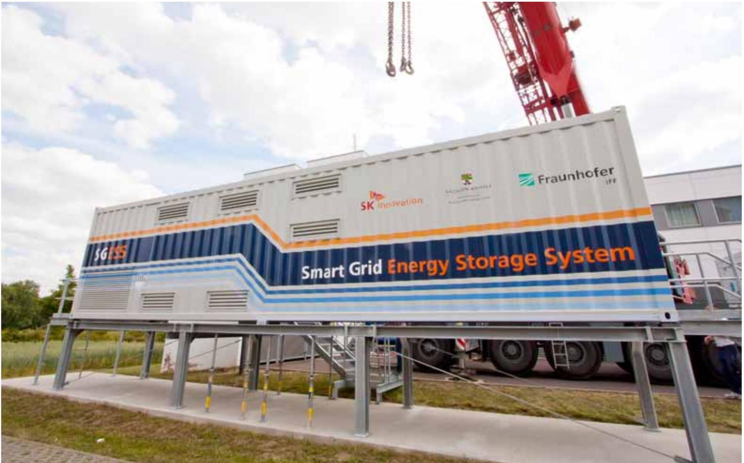
Mobiler Energiespeicher des Fraunhofer IFF. Fünftausend Batteriezellen stecken in dem Container (siehe Bild linke Seite). Fotos: Fraunhofer IFF, Daniela Martin
